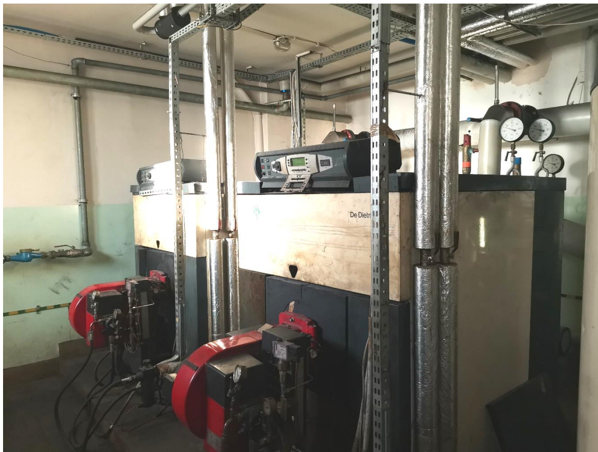
Pomieszczenie kotłowni- istniejące kotły olejowe
