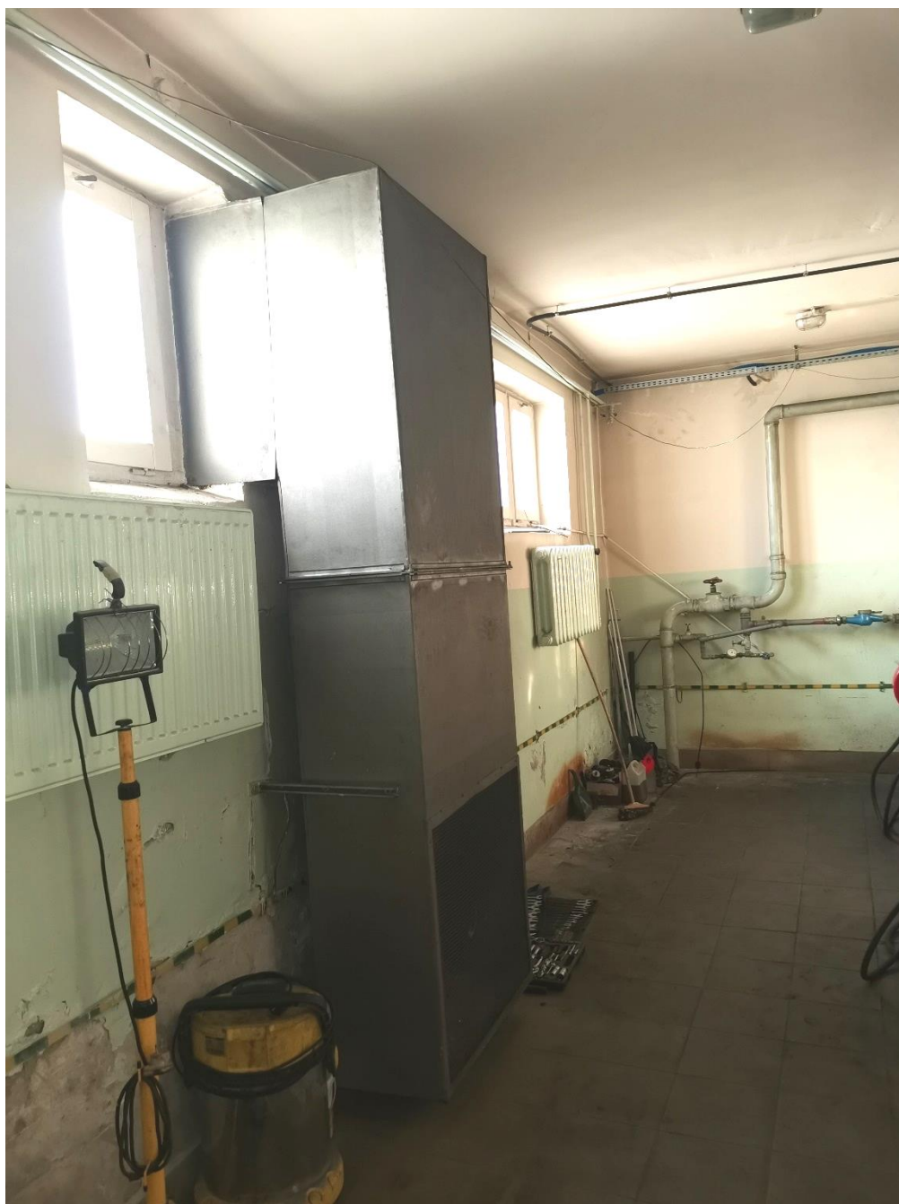
Pomieszczenie kotłowni- kanał nawiewny
