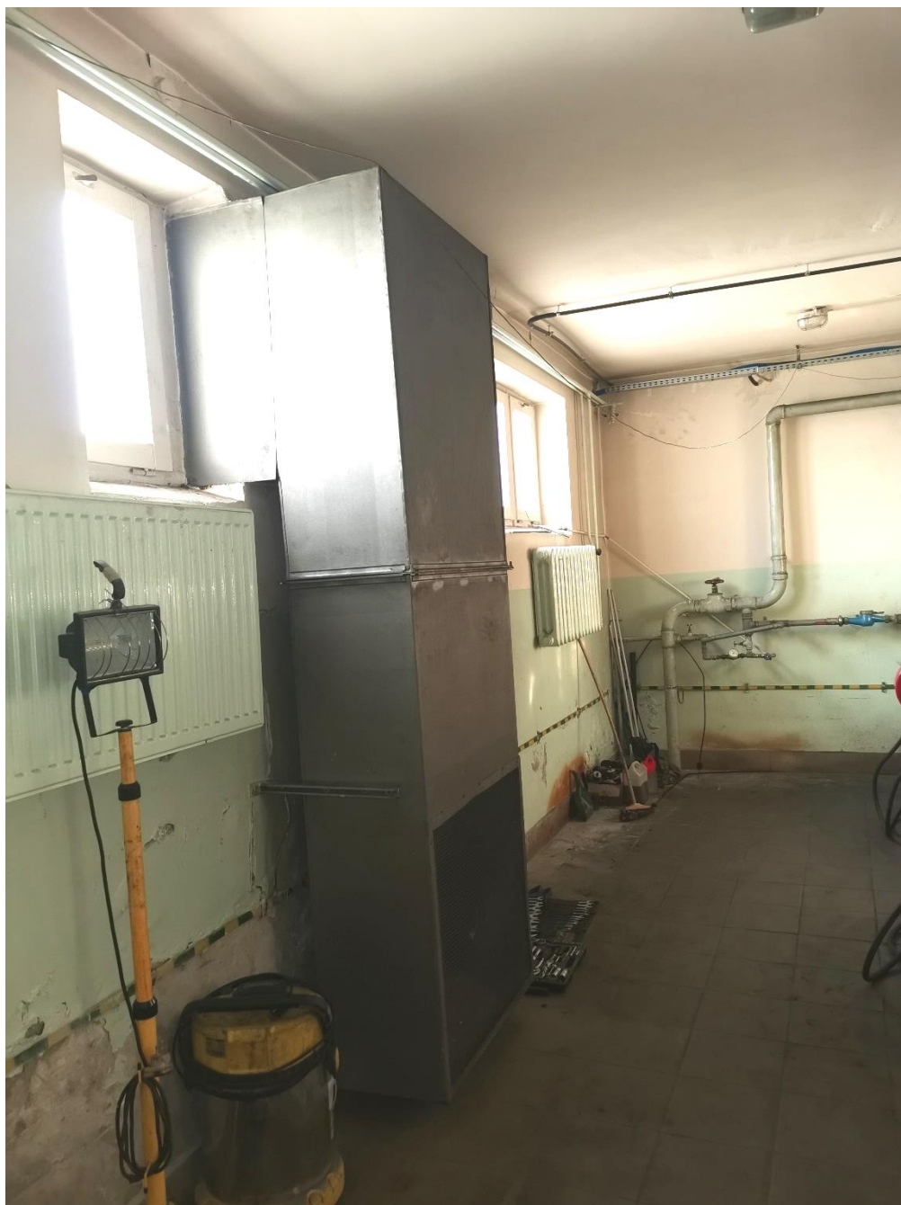
Pomieszczenie kotłowni- kanał nawiewny
