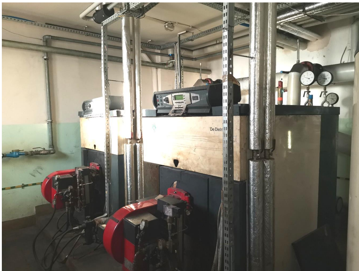
Pomieszczenie kotłowni- istniejące kotły olejowe
