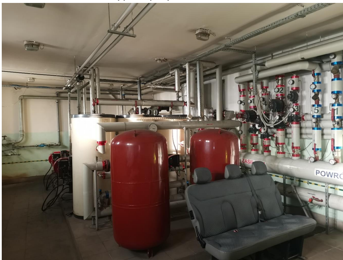
Pomieszczenie kotłowni- zasobniki c.w.u. naczynia wzbiorcze, układ rozdzielaczy
