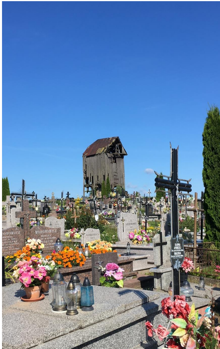
Zdjęcie 12. Zniszczony wiatrak w Minkowicach.
