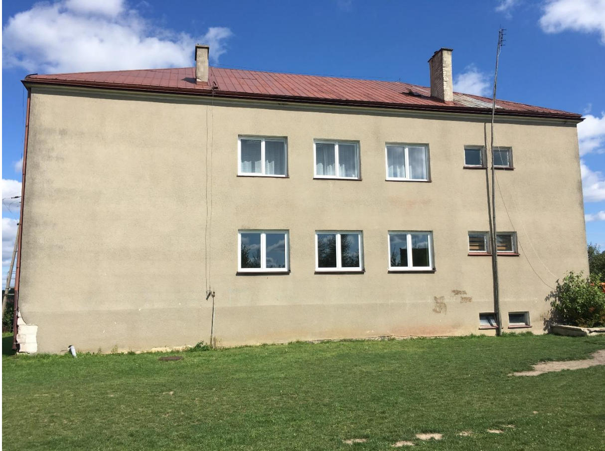
Zdjęcie 18. Budynek remizy w Wierzchlesiu.
