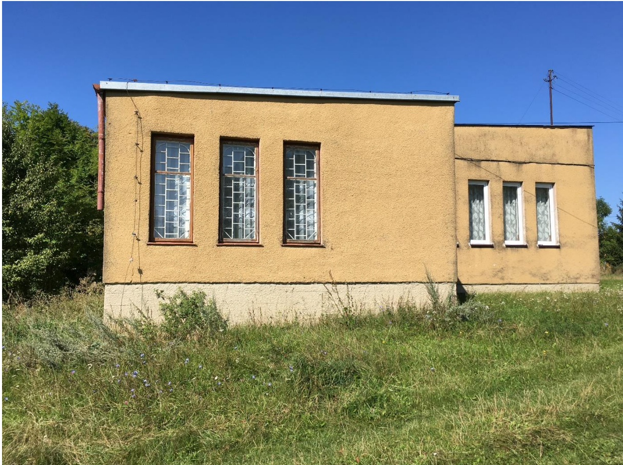
Zdjęcie 16. Budynek remizy w Usnarzu Górnym.
