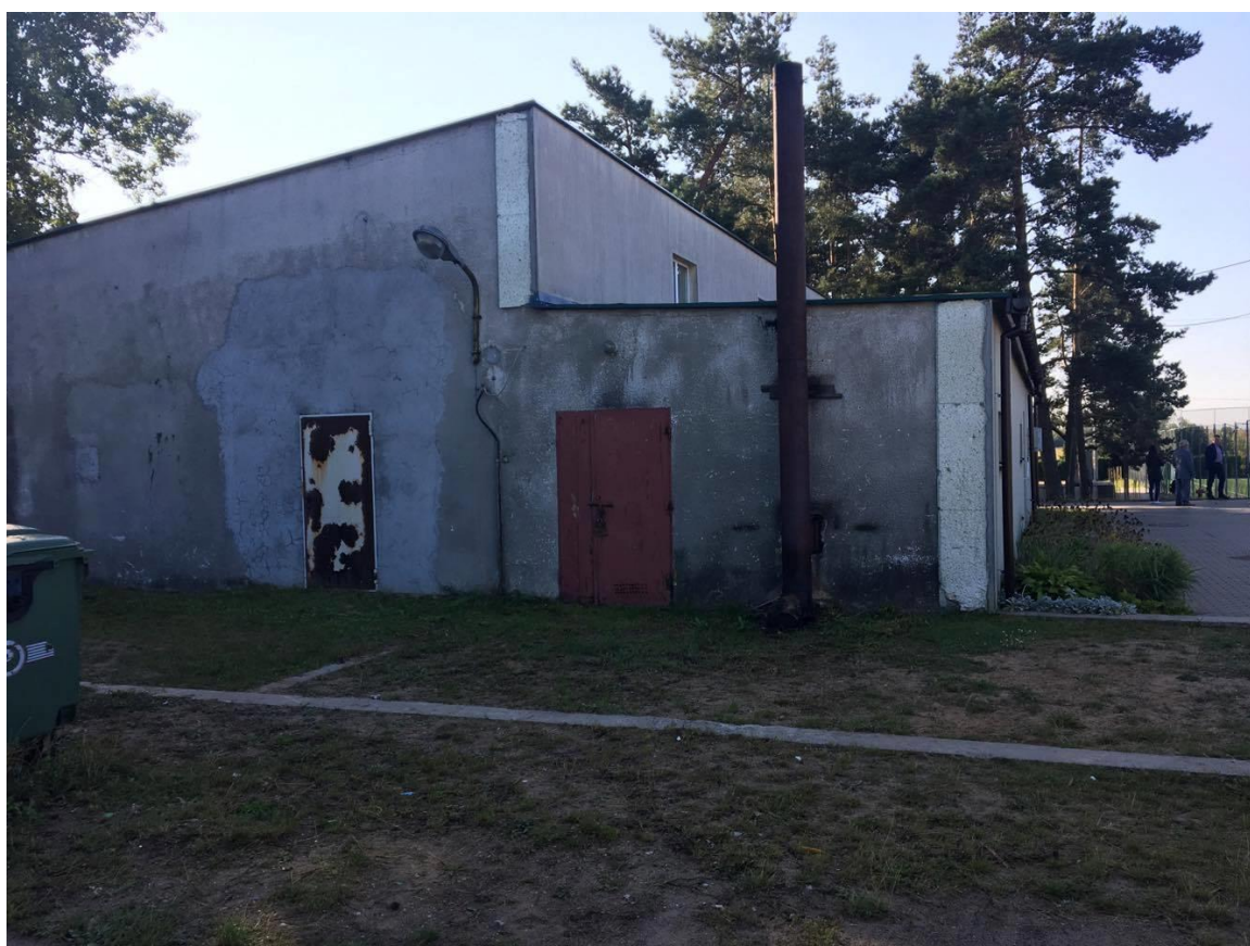
Zdjęcie 5. Zaplecze amfiteatru i kompleksu rekreacyjno-sportowego w Szudziałowie.
